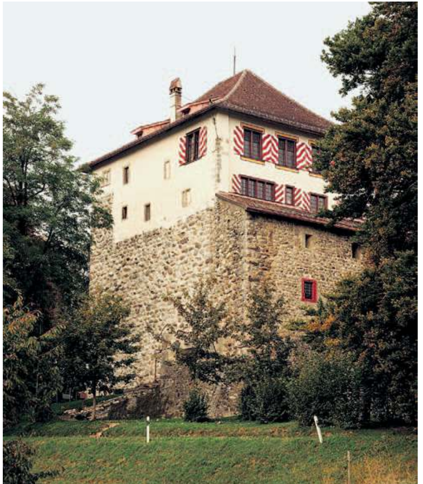
Neue Schindeln unter den Ziegeln, frisches Weiss an den Mauern: Die Mörsburg ist fertig renoviert. Bild: Marc Dahinden
